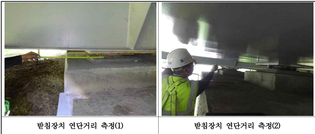
【사진 3.15】교량받침장치 연단거리측정
