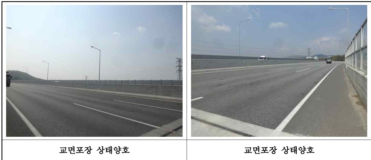
【사진 3.20】 교면포장 손상현황
