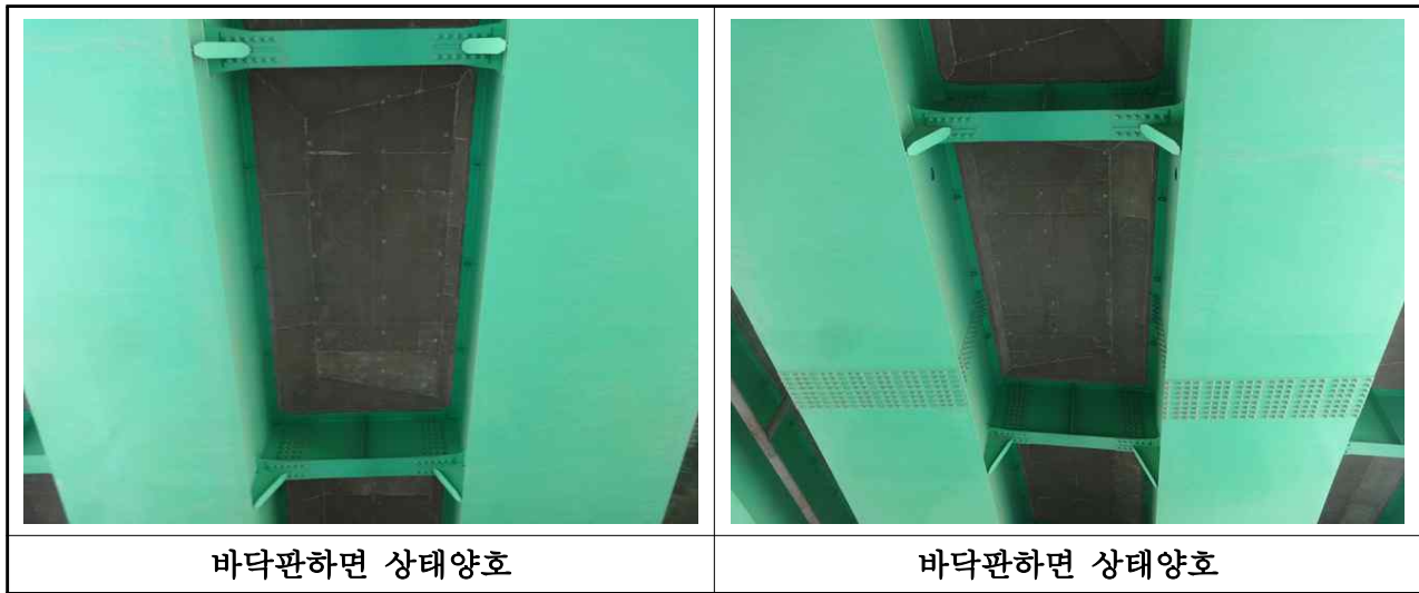
【사진 3.3】 바닥판 손상현황
