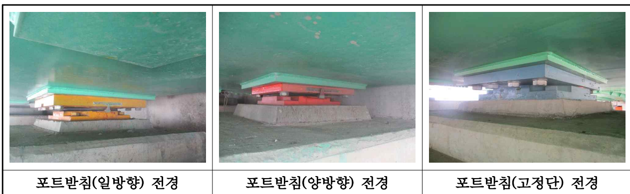
【사진 3.13】 교량받침 전경
