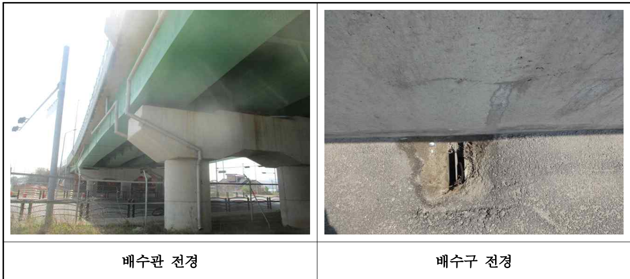
【사진 3.21】 배수시설 전경
